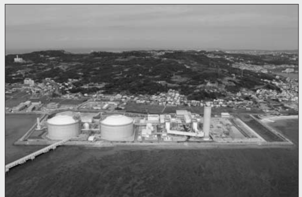
図4 沖縄電力株式会社吉の浦火力発電所 (写真提供：沖縄電力株式会社)
