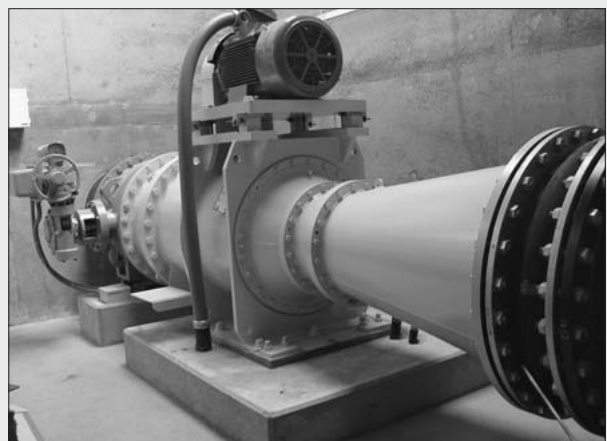
図7 マイクロ水力発電設備
