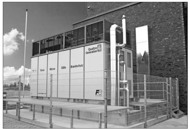
図 6 ヴィスマールに設置した燃料電池
