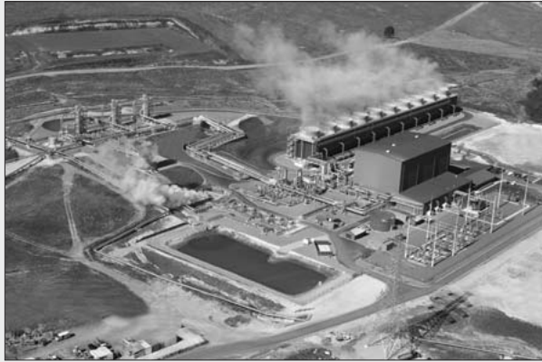
図5 ニュージーランド・ナアワプルーア地熱発電所
