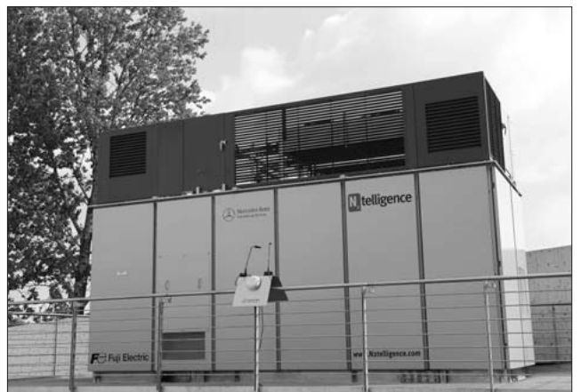
図 7 ハンブルクに設置した燃料電池
