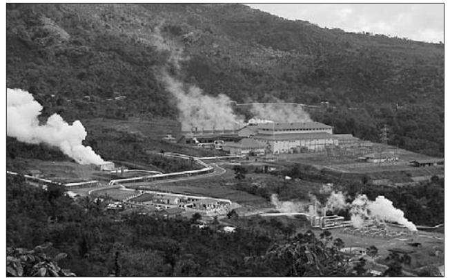
図7 ウルブル地熱発電所の全景
