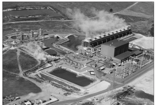
図8 ナアワプ地熱発電所の全景
