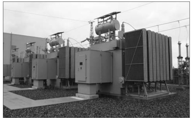
図10 インバータ変圧器
