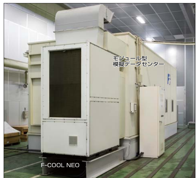
図8 ハイブリッド空調機「F-COOL NEO」評価装置
