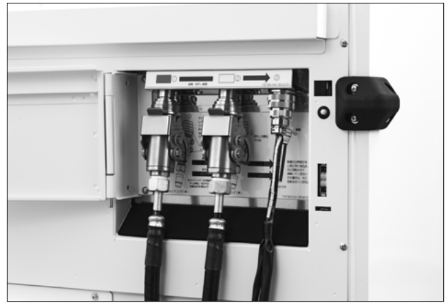
図8 冷媒配管接続部
