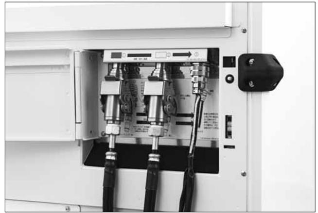
図8 冷媒配管接続部
