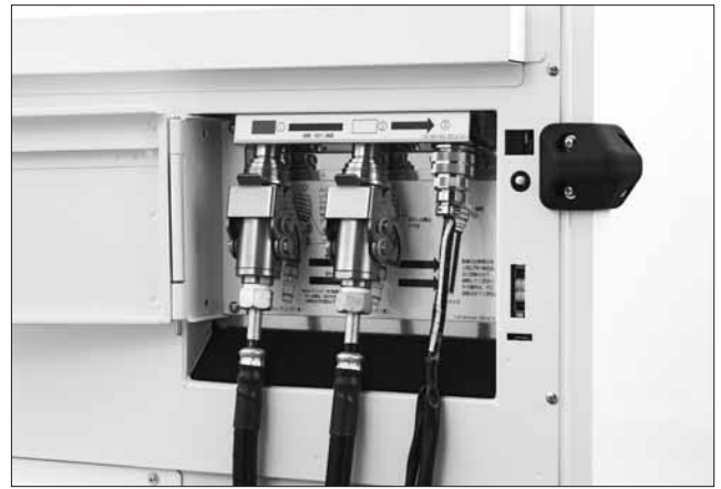
図8 冷媒配管接続部
