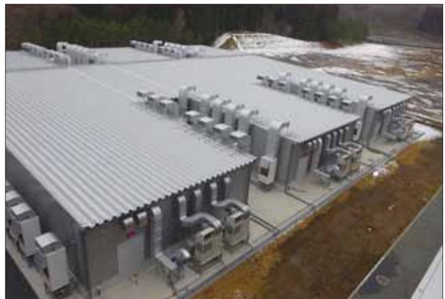
図11 株式会社IDC フロンティア向けモジュール型データセンターの外観
