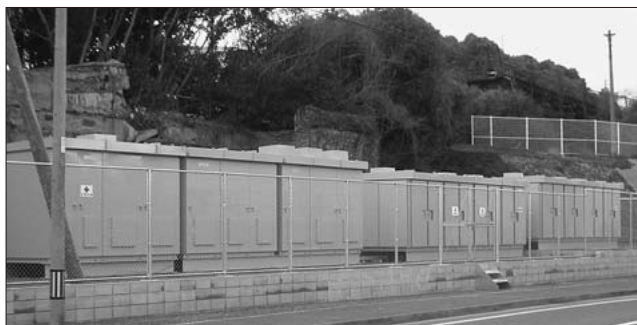
図 4 300 kW 蓄電複合システム
