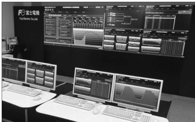
図 3 地域節電所に設置された CEMS
