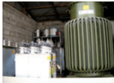
PCB使用機器の保管状況
