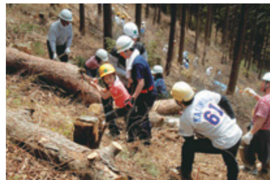
急斜面での作業
