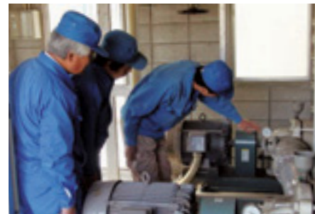
送水ポンプ省エネ診断
