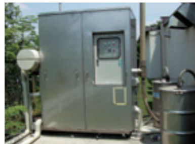
安曇富士のVOC(溶剤)脱気処理装置
