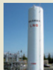
LNG(液化天然ガス)タンク (2008年3月完成)
