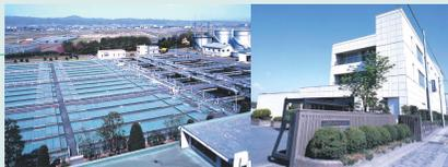
2002年5月に山形市下水道浄化センターで稼働を開始した「りん酸形燃料電池システム」\*は、現在も順調に運転を継続しています。このシステムは、下水から発生するメタンガスを水素に変換し、これを燃料にして発電を行うことが特徴です。高効率なエネルギー利用とともに、温暖化抑制効果に対しても期待が高まっています。現地には多数の見学者が訪れ、小学生にも好評です。
