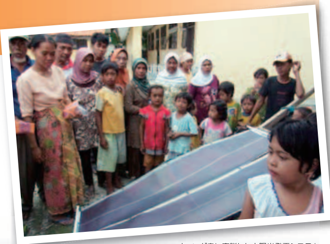
トゥンダ島に寄贈した太陽光発電システム
