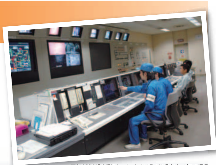
西多摩衛生組合環境センターにおける点検保全サービスの現場
