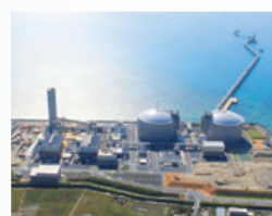
ガスタービン・コンバインドサイクル発電設備を納入 (沖縄電力(株) 吉の浦火力発電所)
