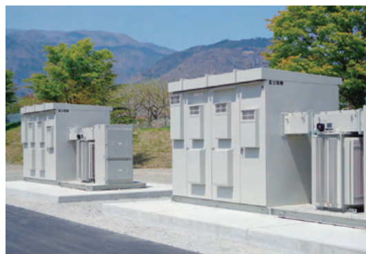
パワーコンディショナ (1MW×2台)
