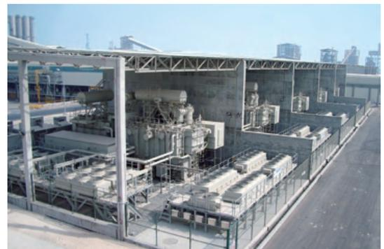
EMAL社のアルミ製錬工場。写真は第一期のSフォーマ(12台納入済)。現在施工中の第二期工事(6台納入予定)が完成すれば、世界最大級のアルミ製錬所となる
