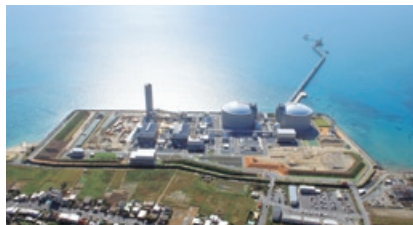
沖縄電力様 吉の浦火力発電所
