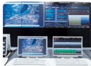
地域エネルギー管理システム
