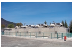
電気・熱エネルギー技術の当社モデル工場への適用例（燃料電池）
