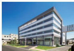
松本工場 技術開発棟
