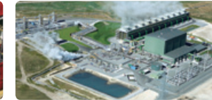
地熱発電設備
