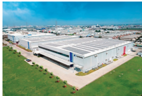
富士電機マニュファクチャリング (タイランド) 社 システム工場
