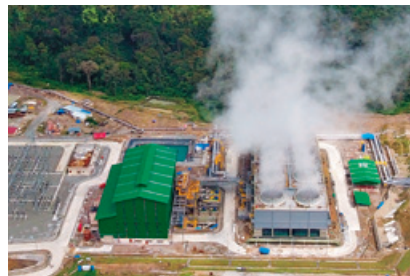
ムアララボ地熱発電所
