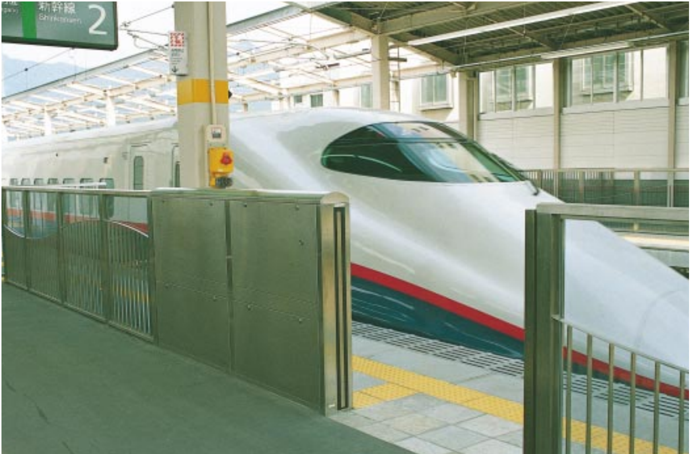
駆動用リニアモータ使用の新幹線ホーム可動柵 Liner motor driving system for safety fence of platform
