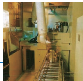
固体廃棄物処理搬送設備
