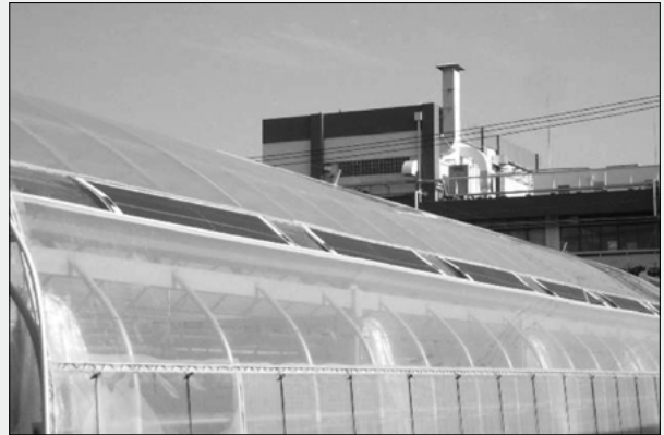
図10 簡易設置型モジュールの設置例
