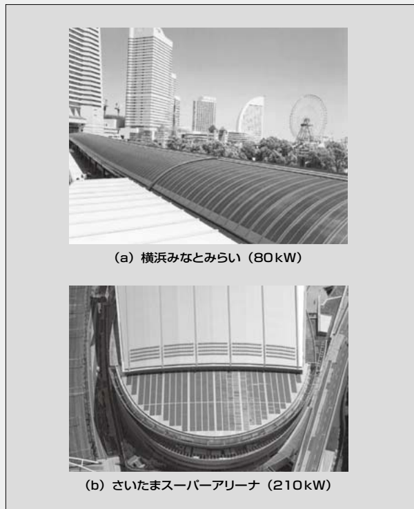
図6 銅板一体型太陽電池モジュールの設置例
