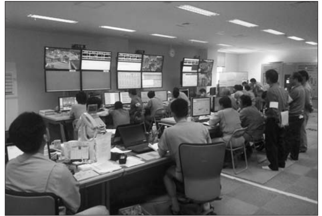
図3 負荷遮断試験時の中央操作室
