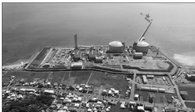
図1 吉の浦火力発電所の全景
