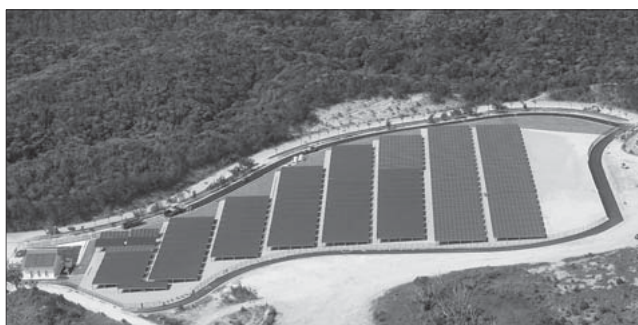
図5 安部メガソーラーの全景 (写真提供：沖縄電力株式会社)
