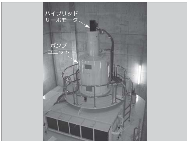
図1 ランナベーン開閉操作用ハイブリッドサーボモータ
