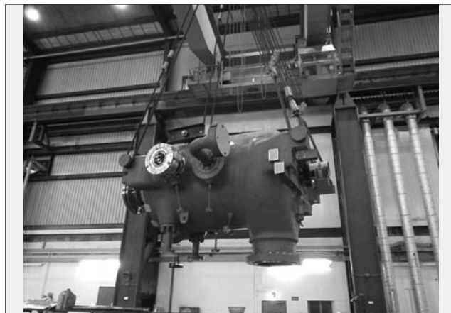
図6 現地更新工事中の12号機高圧タービン
