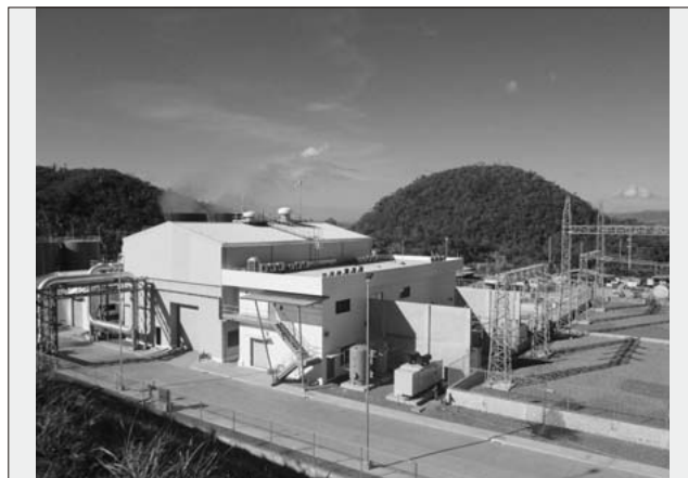
図5 マイバララ地熱発電所全景
