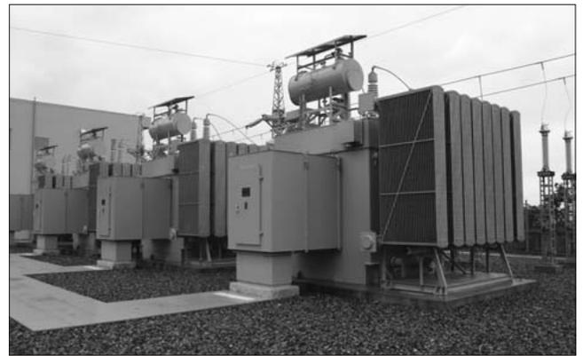
図10 インバータ変圧器
