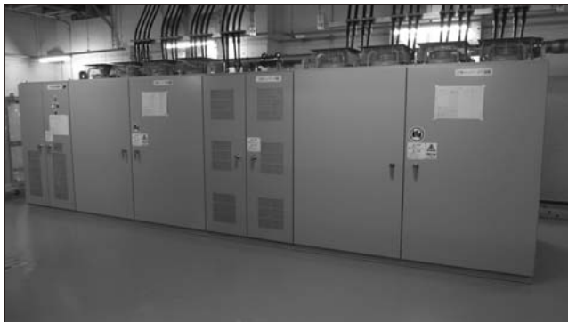
図6 インバータ装置
