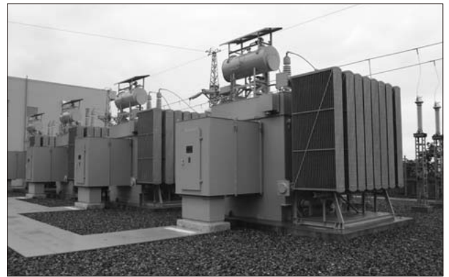
図10 インバータ変圧器
