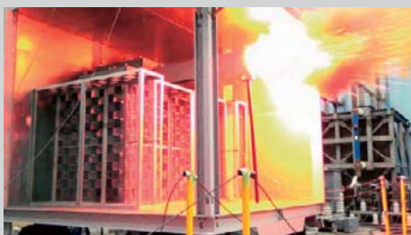
(b) 配電盤内部アーク試験の様子（第三者認証試験）
