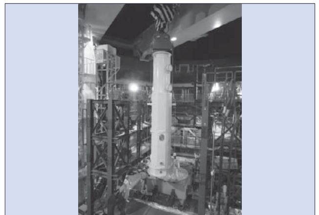
図8 原子炉格納容器内における回収作業
