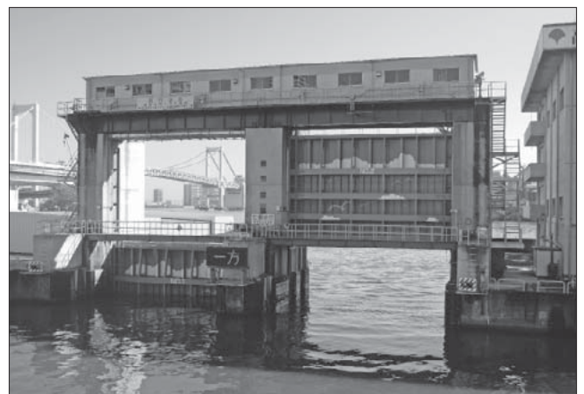
図3 高浜水門全景
