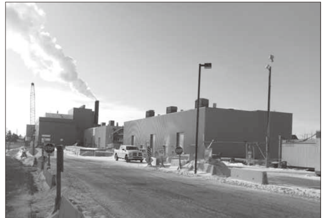
図2 拡張工事中のクイーンエリザベス発電所
