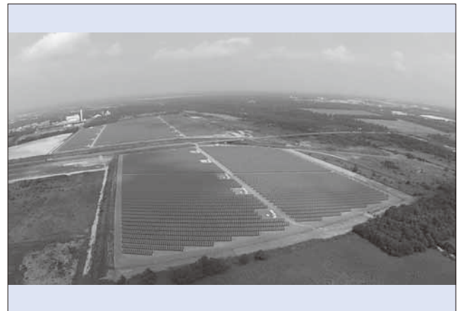
図7 とまこまい勇払メガソーラー発電所 A、B 地区全景
