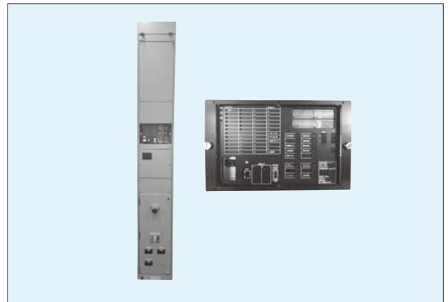
図1 新デジタル形送電線保護リレー装置
