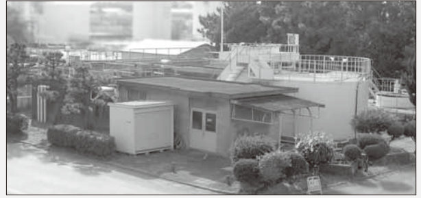
図8 排水処理施設
