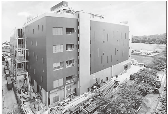
図11 キングスランド社データセンターの外観
