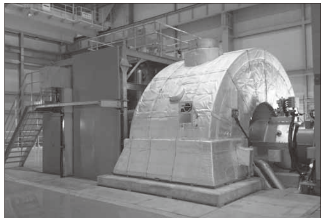
図2 再熱蒸気タービン
