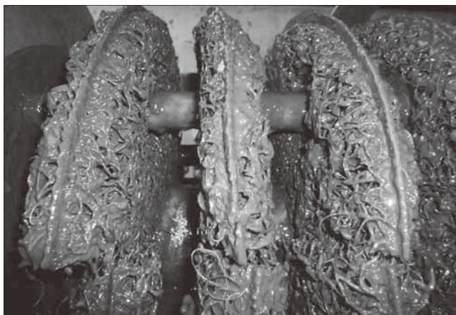
図5 回転円板装置の接触体（汚泥付着状態）
