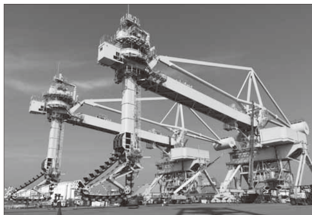
図9 連続アンローダの全景
