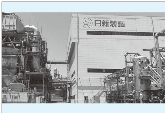
図12 呉製鉄所6号ボイラ・11号タービン発電設備
