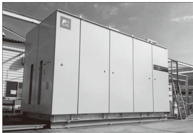
図7 業務用固体酸化物形燃料電池（実証機システム）
