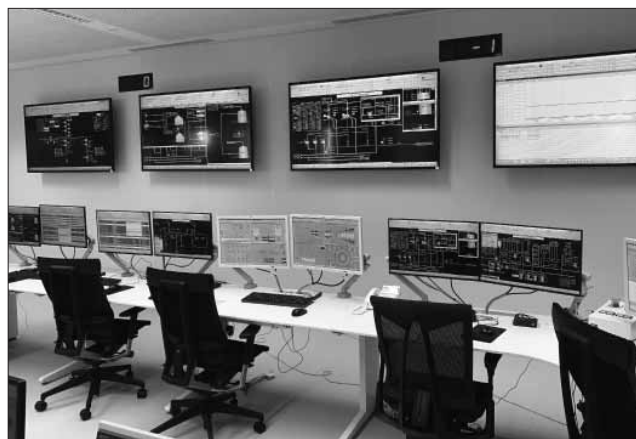
図15 真岡発電所の中央操作室
