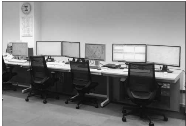
図2 配電自動化システム（指令室）
