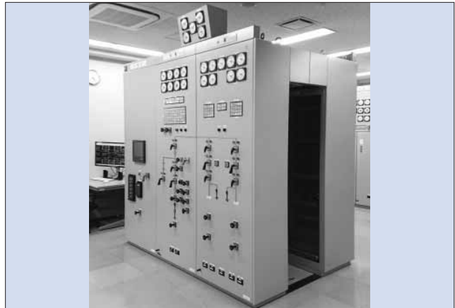
図1 監視制御盤の外観
