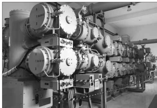
図 4 オマーン・Bousher 変電所 145 kV GIS
