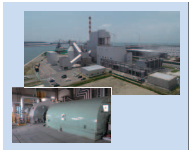
図 12 サミット酒田パワー株式会社 酒田バイオマス発電所
