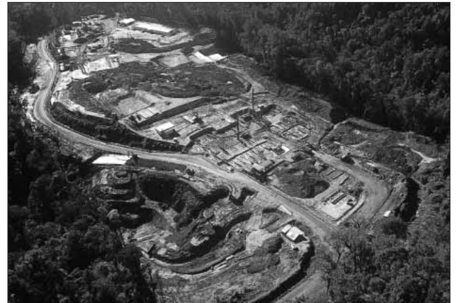
図1 発電所エリア工事中写真
