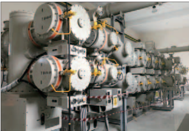
図3 オマーン・Bousher 変電所 145kV GIS
