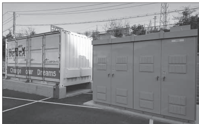
図 1 EV リユース蓄電池システム
