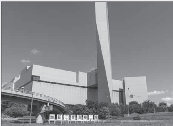
図8 日本最大の清掃工場（新江東清掃工場） （東京二十三区清掃一部事務組合提供・協力）
