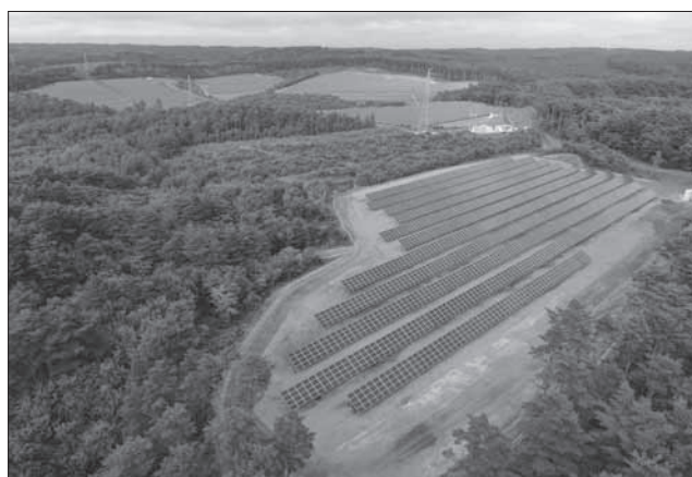
図 6 久慈待浜太陽光発電所の全景
