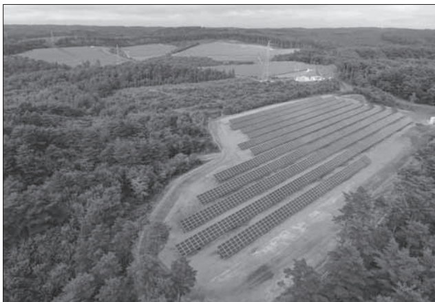
図 6 久慈待浜太陽光発電所の全景
