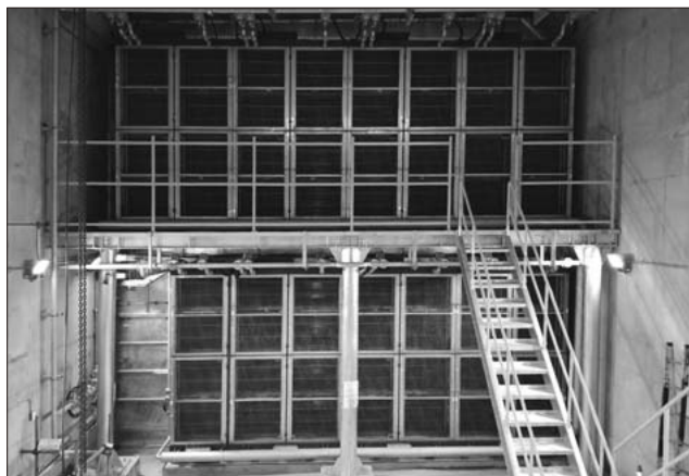
図 22 ソウル済物浦トンネル 1 工区向け電気集じん機
