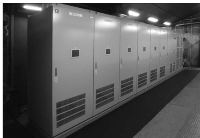
図 7 粗列用 3 レベルインバータ制御装置
