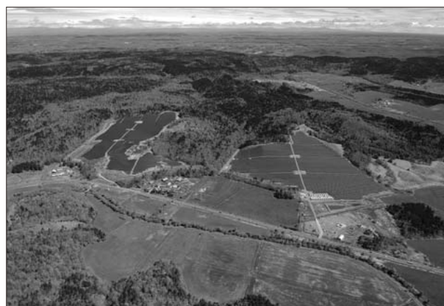
図 2 尾幌太陽光発電所の全景
