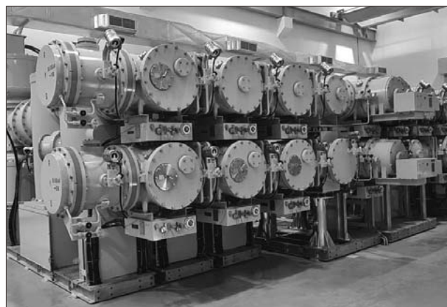
図6 新型145 kV ガス絶縁開閉装置
