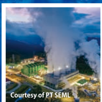
Courtesy of PT SEMI 耐食・材料・熱水利用技術 地熱発電プラント
