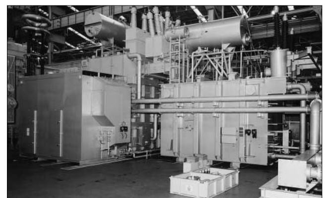
図3 工場での通電試験状況
