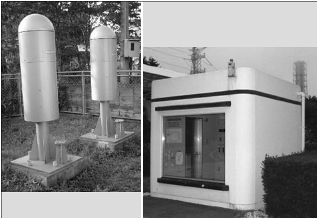
図2 モニタリングポストの設置例
