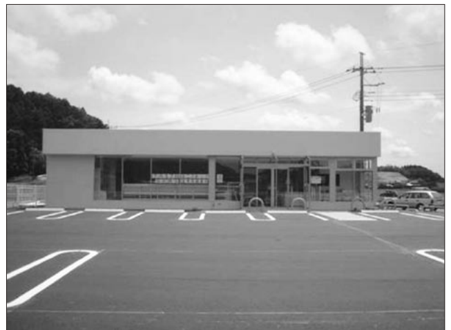
図7 エコロユニットの完成写真
