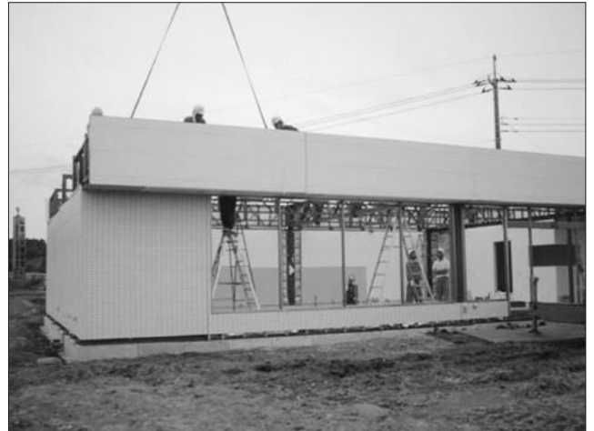
図6 工場製作の屋根ユニット（現場設置状況）
