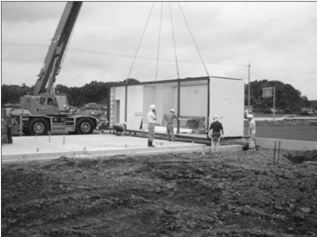
図5 工場製作の本体ユニット（現場設置状況）
